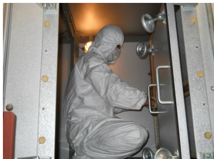
写真2 HEPA フィルタ交換作業中の筆者
