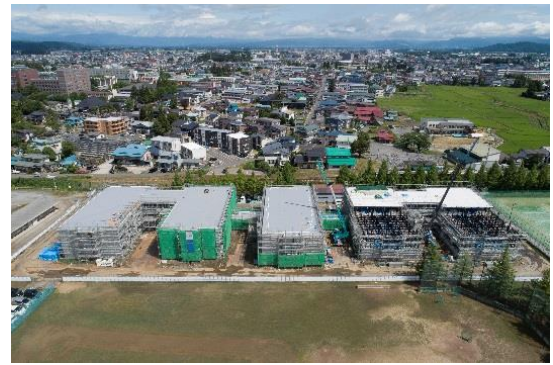
写真.8 学生寮建設の様子(全景)
