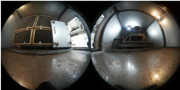
写真 2 HEPA フィルタ内部 (左)元画像
